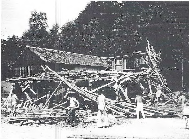
August 1977: Der EHC Bassersdorf übernimmt den Abbruch der Dreschscheune.
