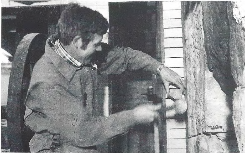
Der letzte der 195 Zahnrohlinge wird am grossen Kammrad ein- gesetzt.
