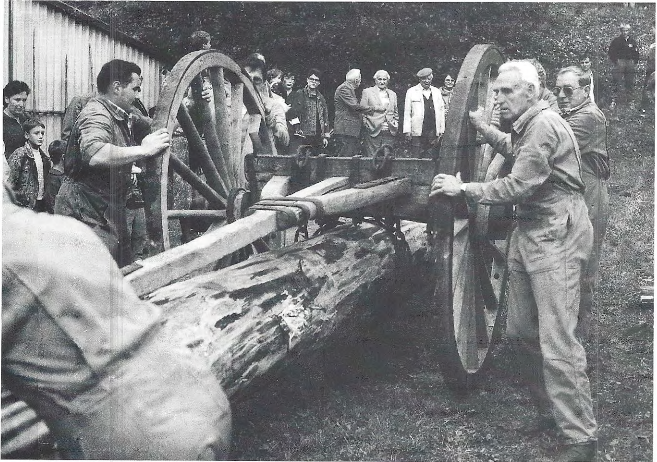
Am 10-jährigen Jubiläum der Restaurierung wurden ehemalige Arbeitsmethoden demonstriert: Holztransport mit Unterhängewagen.
