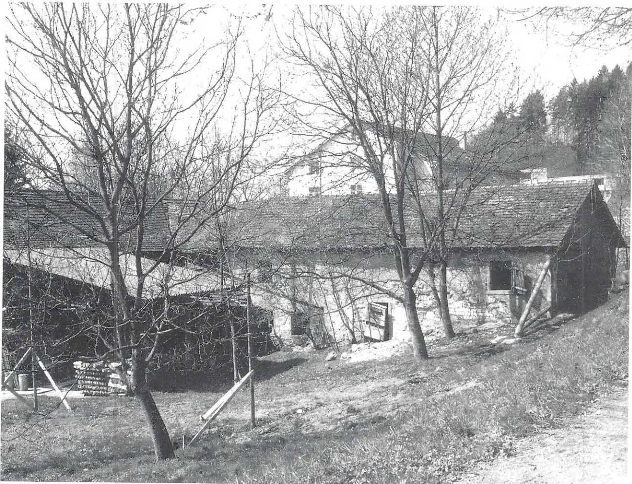
1975: Ansicht von SO. Zugang zum Radhaus durch eine kleine Türe. Diese Maueröffnung wurde soweit vergrössert, dass das Wasserrad nun in seiner ganzen Grösse sichtbar ist.
