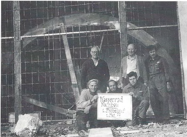
1. Oktober 1977: Erster Probelauf des fertig montierten Wasserrades. Die erste Hürde ist genommen!
